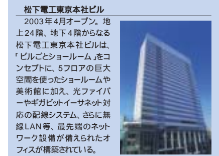
松下電工東京本社ビル
