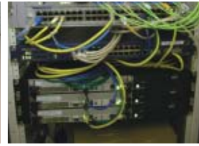
150のアクセスポイントを3台のコントローラが制御する
