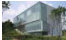
天竜川沿いの高台にある東洋芦機製造の新本社ビル
