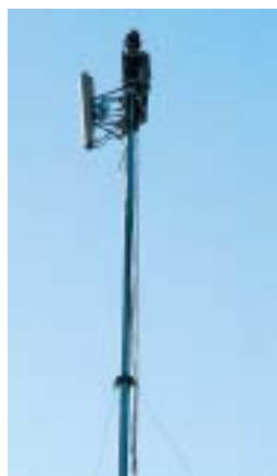
昨年10月にスイス・ジュネーブで開催されたITU Telecom World 2009では、中国移动はモトローラと共同でTD-LTEの試験設備を構築、車両による走行デモを実施した。右はデモに使われた2.6GHz帯の基地局アンテナ
